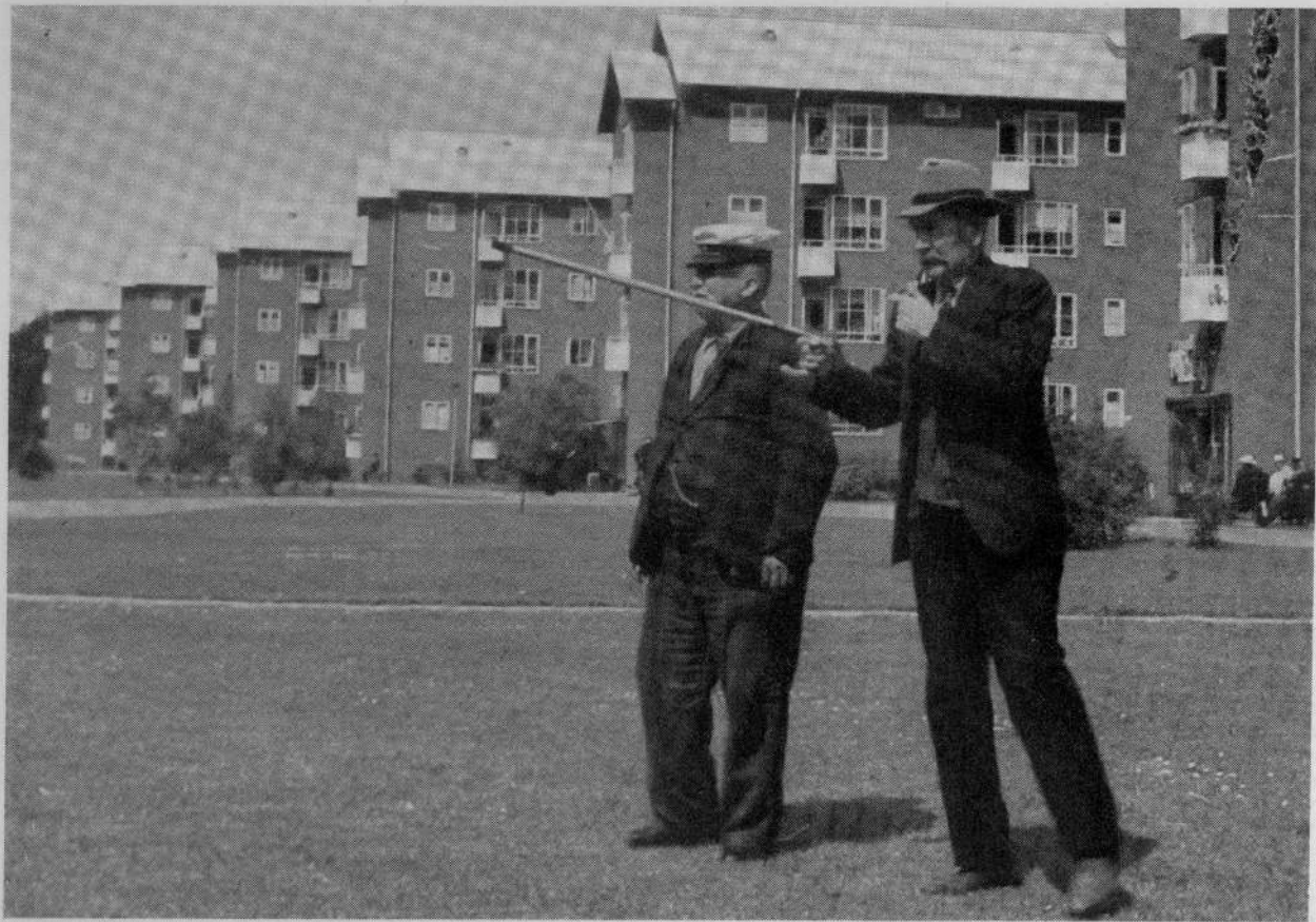
Ospizio per i vecchi, capace di 450 appartamenti, costruito dal Comune di Copenhagen.
