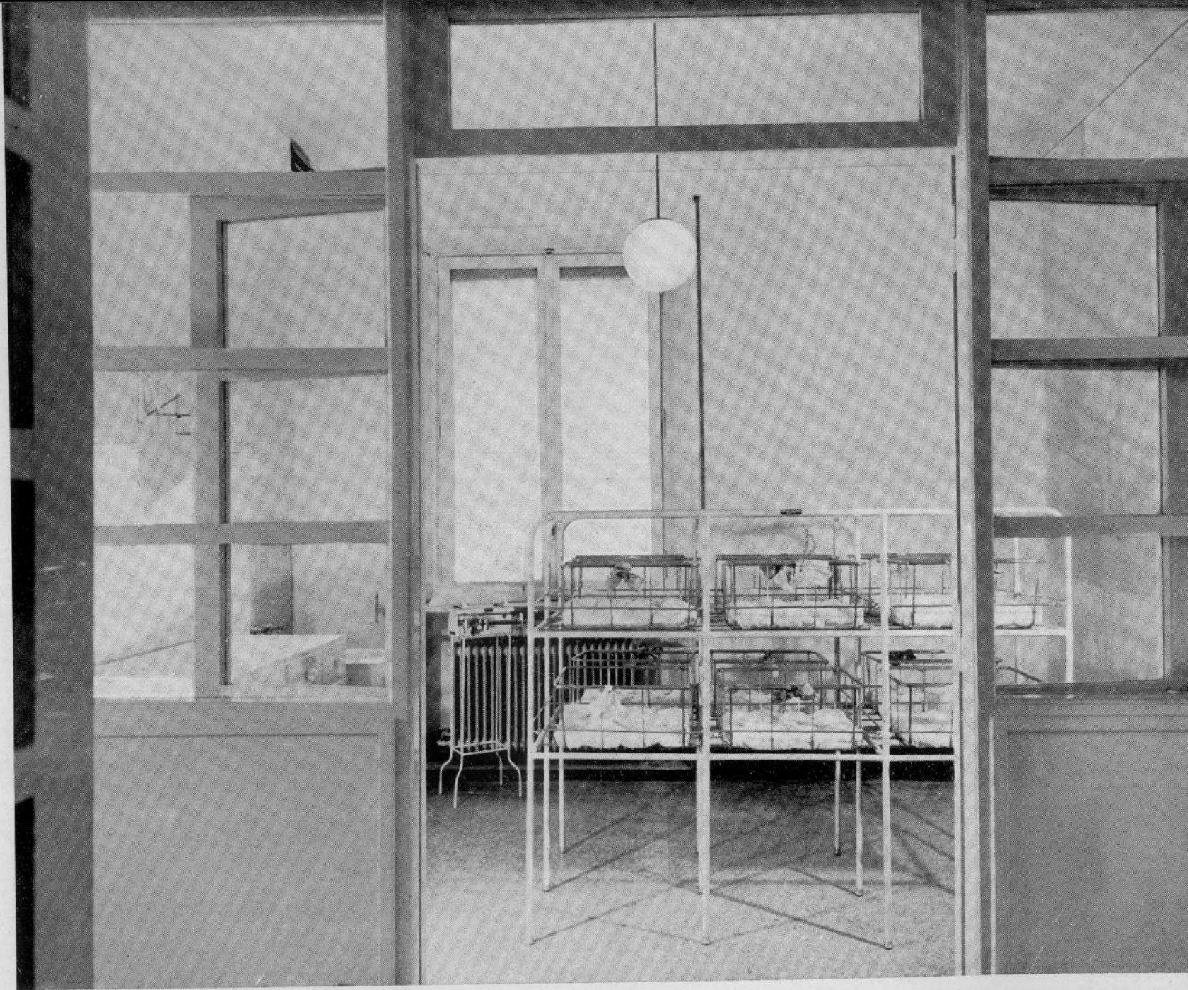
SALA PREMATURI CON IMPIANTO AD ARIA CONDIZIONATA
