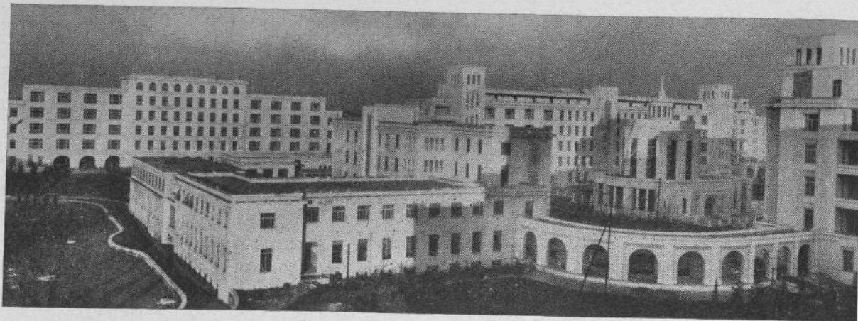
A destra in fondo un padiglione di medicina. A sinistra il padiglione di ostetricia e ginecologia. In primo piano il padiglione dei servizi generali.
