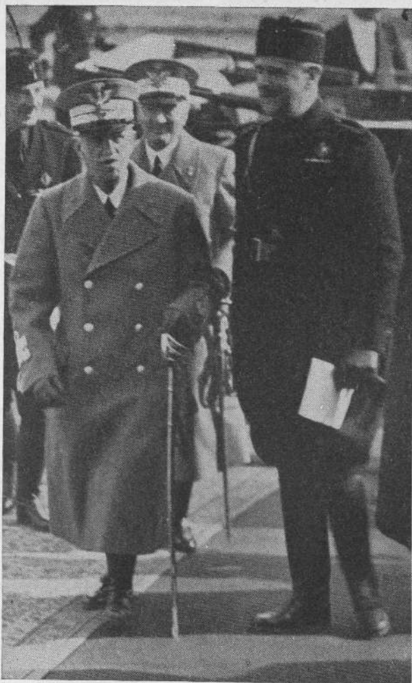
S. M. il Re Imperatore accompagnato dal Presidente dell'Ospedale Maggiore avv. Della Porta, visita i lavori del Nuovo Ospedale Maggiore.
