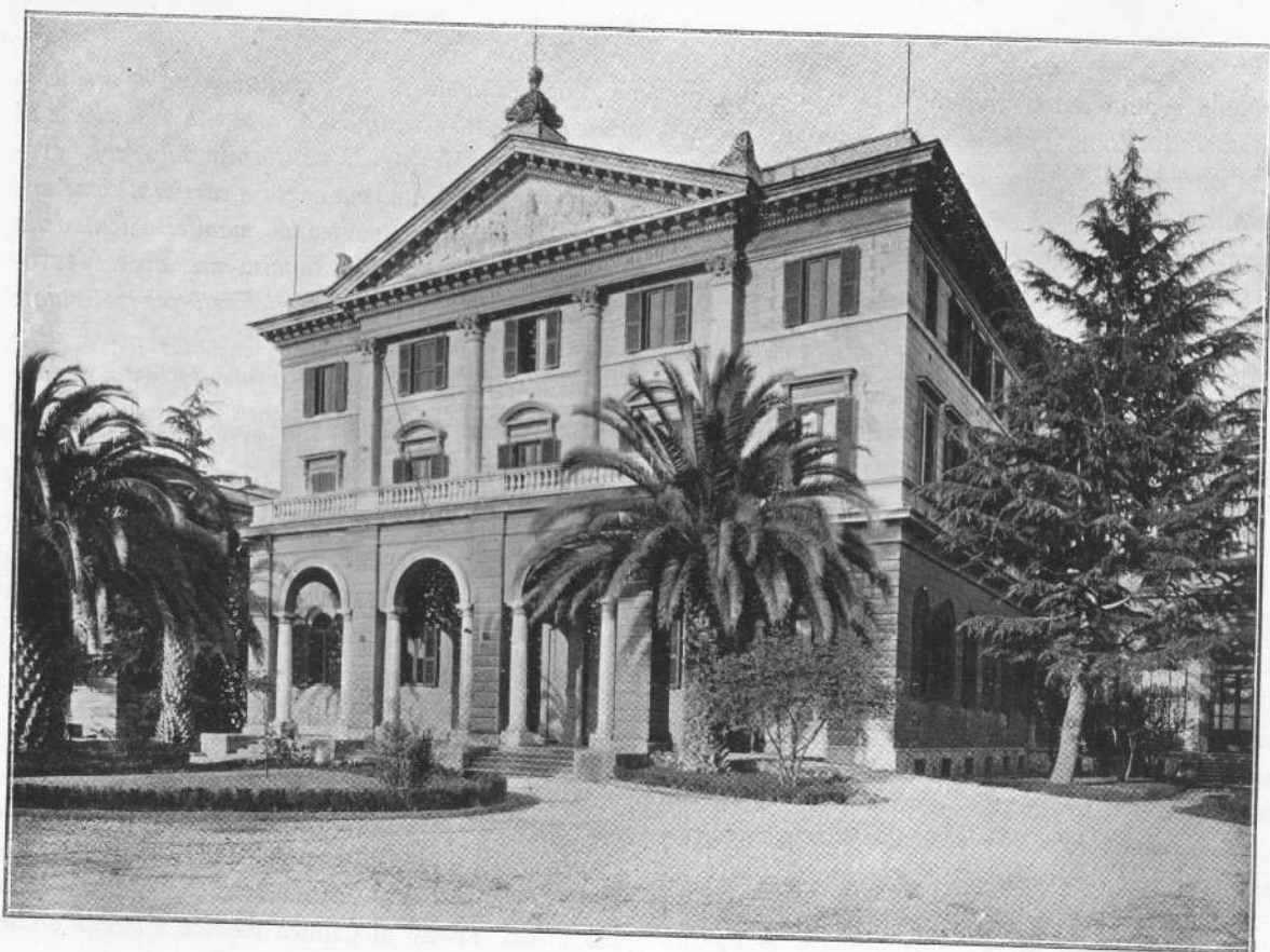
FIG. 1. — FACCIATA ESTERNA DELL'ISTITUTO.
